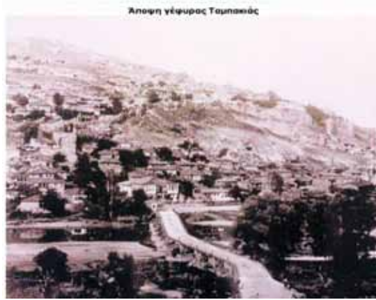
Αποψη γέφυρας Ταμπουλιάς
